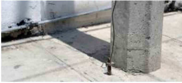
Figuras 12, 13 y 14. Casos típicos de banquetas con obstrucciones
