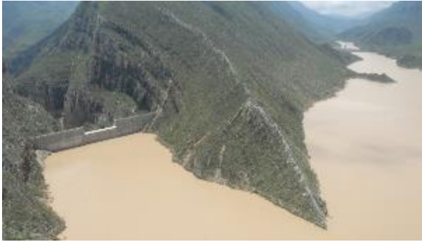
Figura 32. Rompe Picos, Huracán Alex 2010 Fuente: U-ERRE
